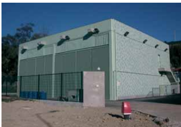
Nova Subestação AT/MT - Amadora
