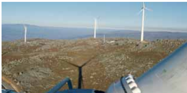
Parque Eólico Fonte da Queilha
