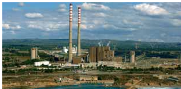
Central Termoelectrica de Sines
