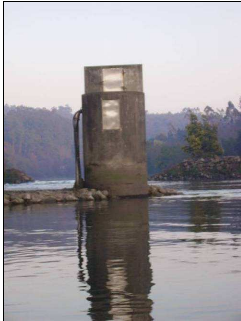
FIG. 91 – Açude 8 e Ponto de Captação (41°31'22.9" N, 008°40'06.7" W)
