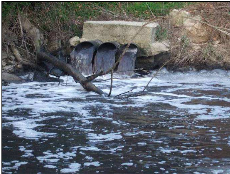
FIG. 76 – Descarga da ETAR de Barcelos (41°31'13.0" N, 008°38'48.3"W)
