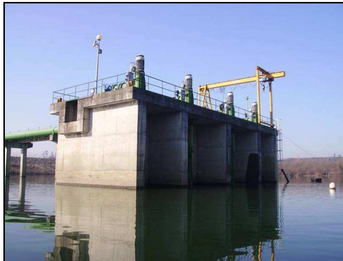
FIG. 74 – Captação de Água da ETA de Areias de Vilar (41°32'53.8" N, 008°32'26.5" W)
