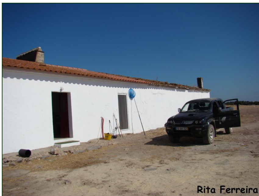
Figura 15 – Reconstrução de casa degradada, como base de apoio ao projecto.
