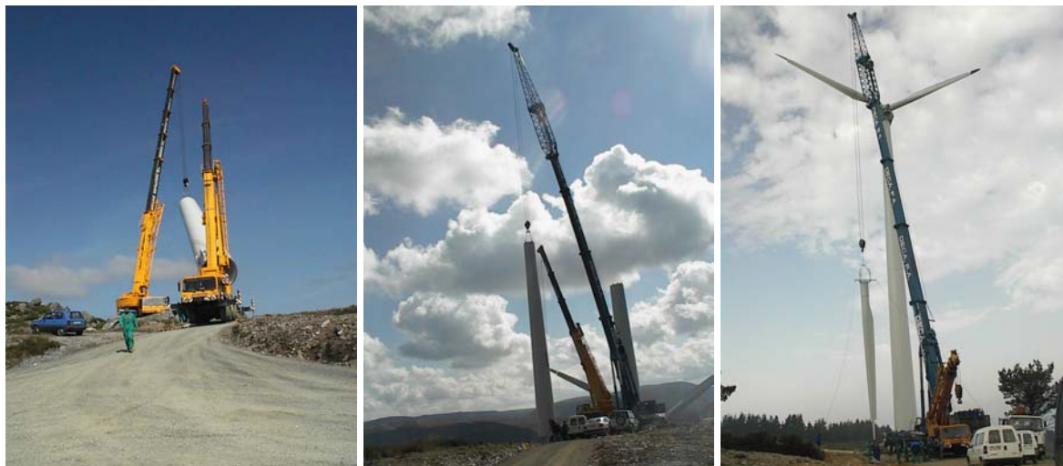
Figuras 12, 13 e 14 – Montagem de um aerogerador
