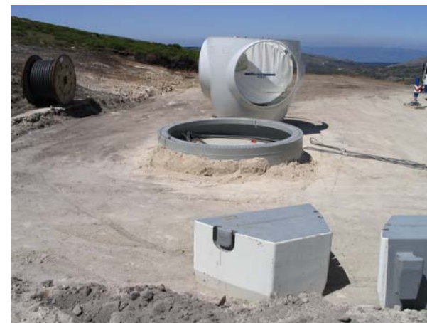
Figura 18 – Aspecto da sapata antes da colocação da torre
