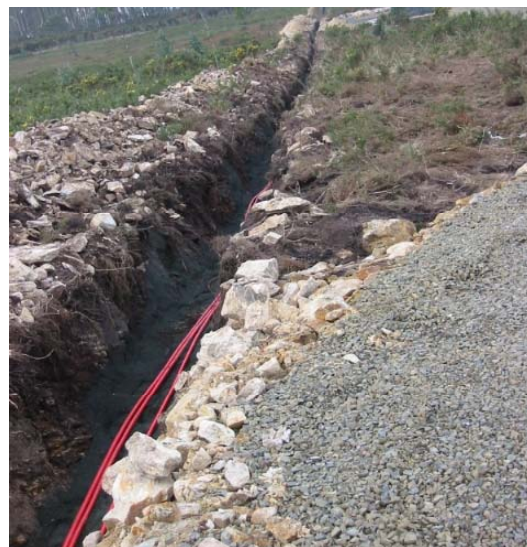
Figura 17 – Aspecto de uma vala para enterramento de cabos eléctricos
