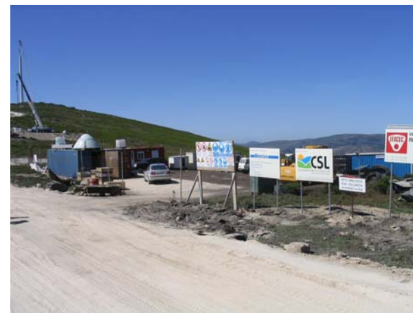
Figura 15 – Aspecto de um estaleiro
