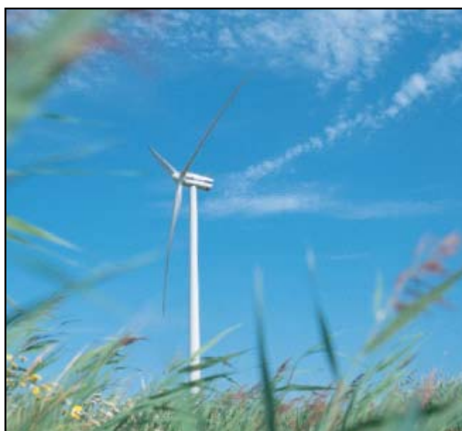
Figura 4 - Aerogerador VESTAS V90 (1800 kW)
