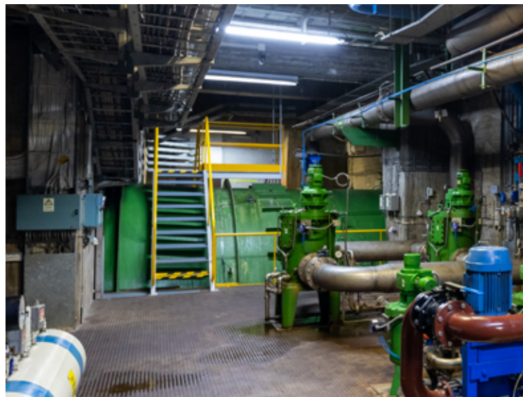
Barragem da Aguieira
