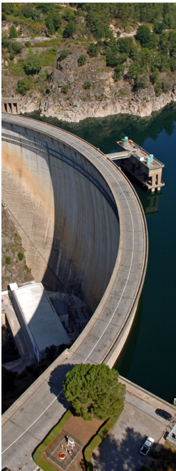
Barragem do Cabril
