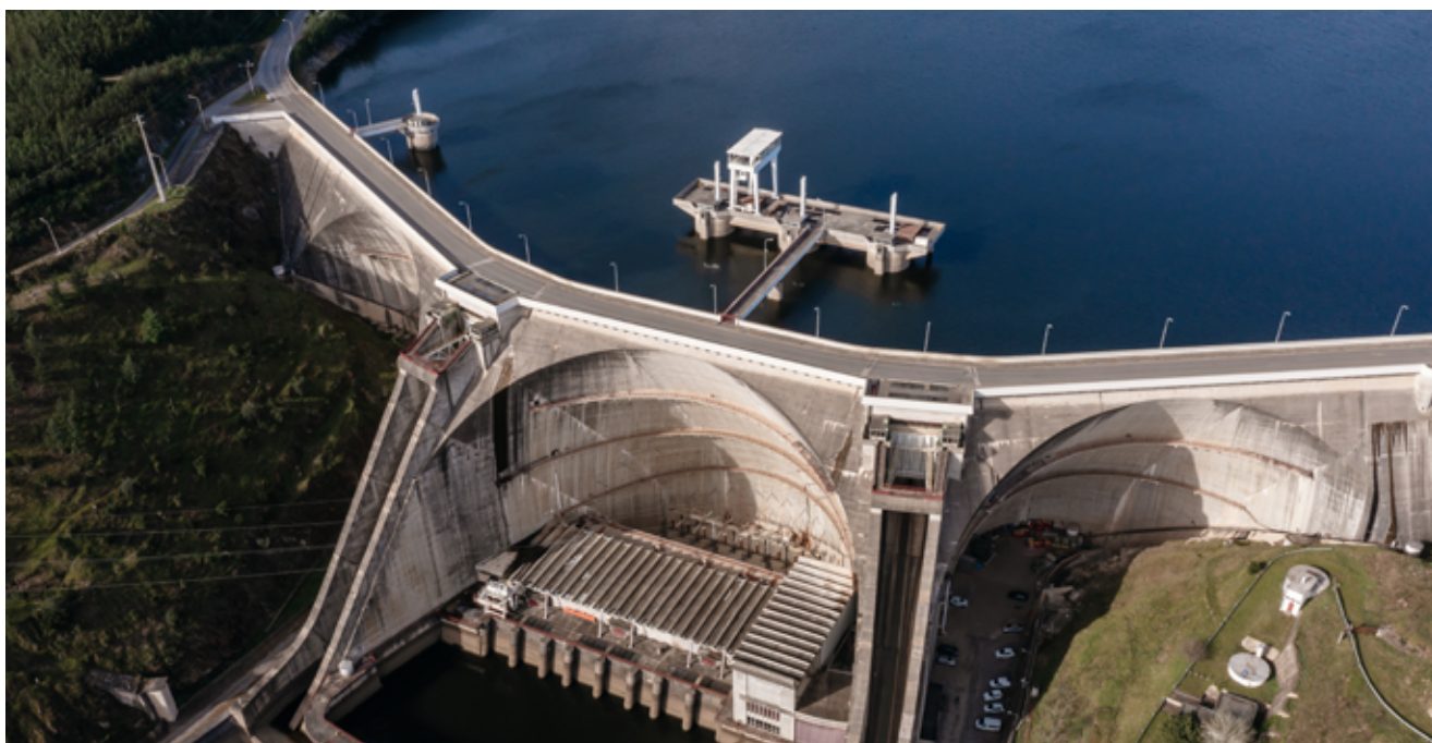
Barragem da Aguieira
