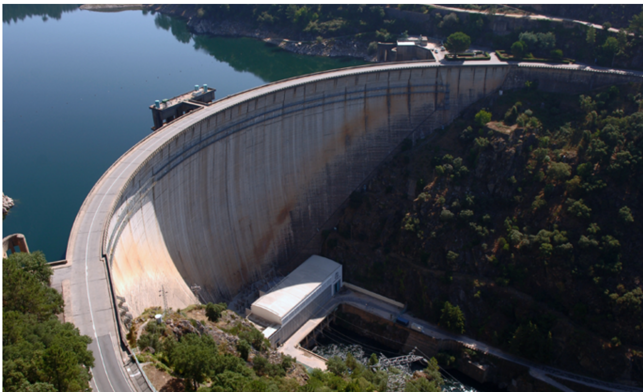
Barragem do Cabril
