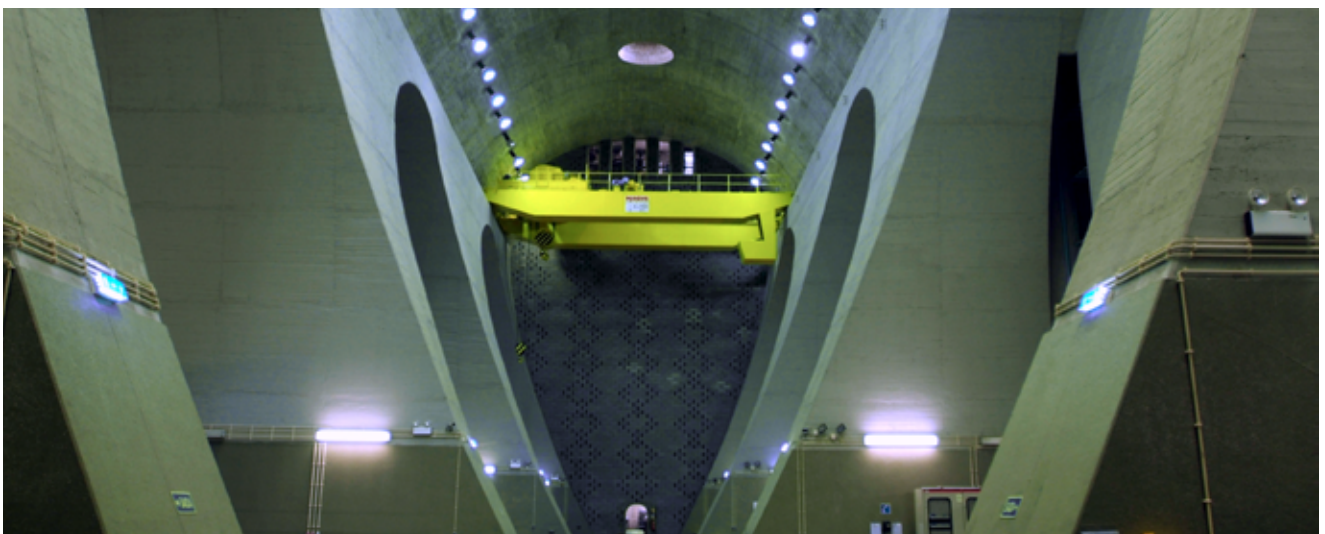
Barragem de Fratel
