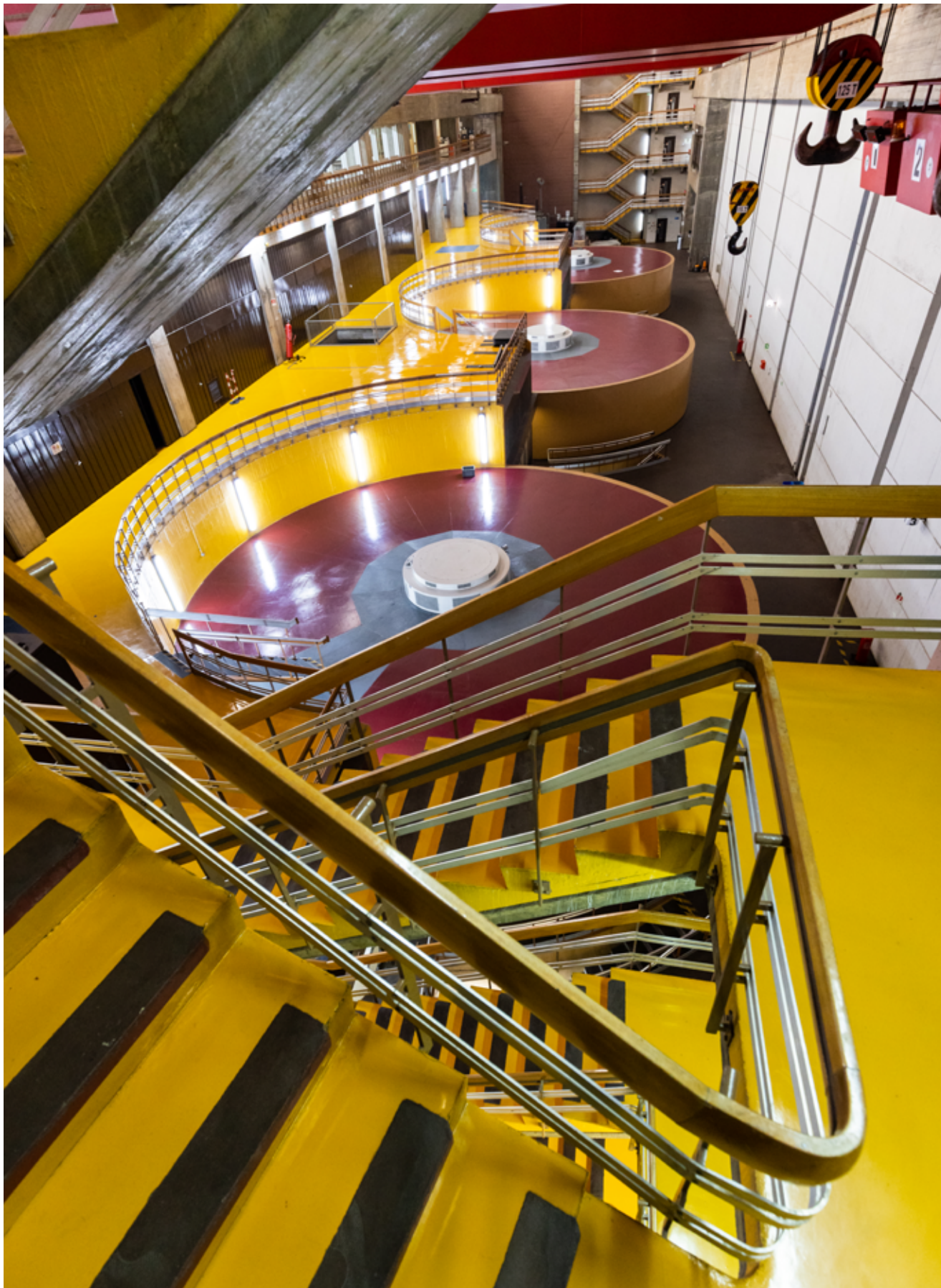
Barragem da Aguieira
