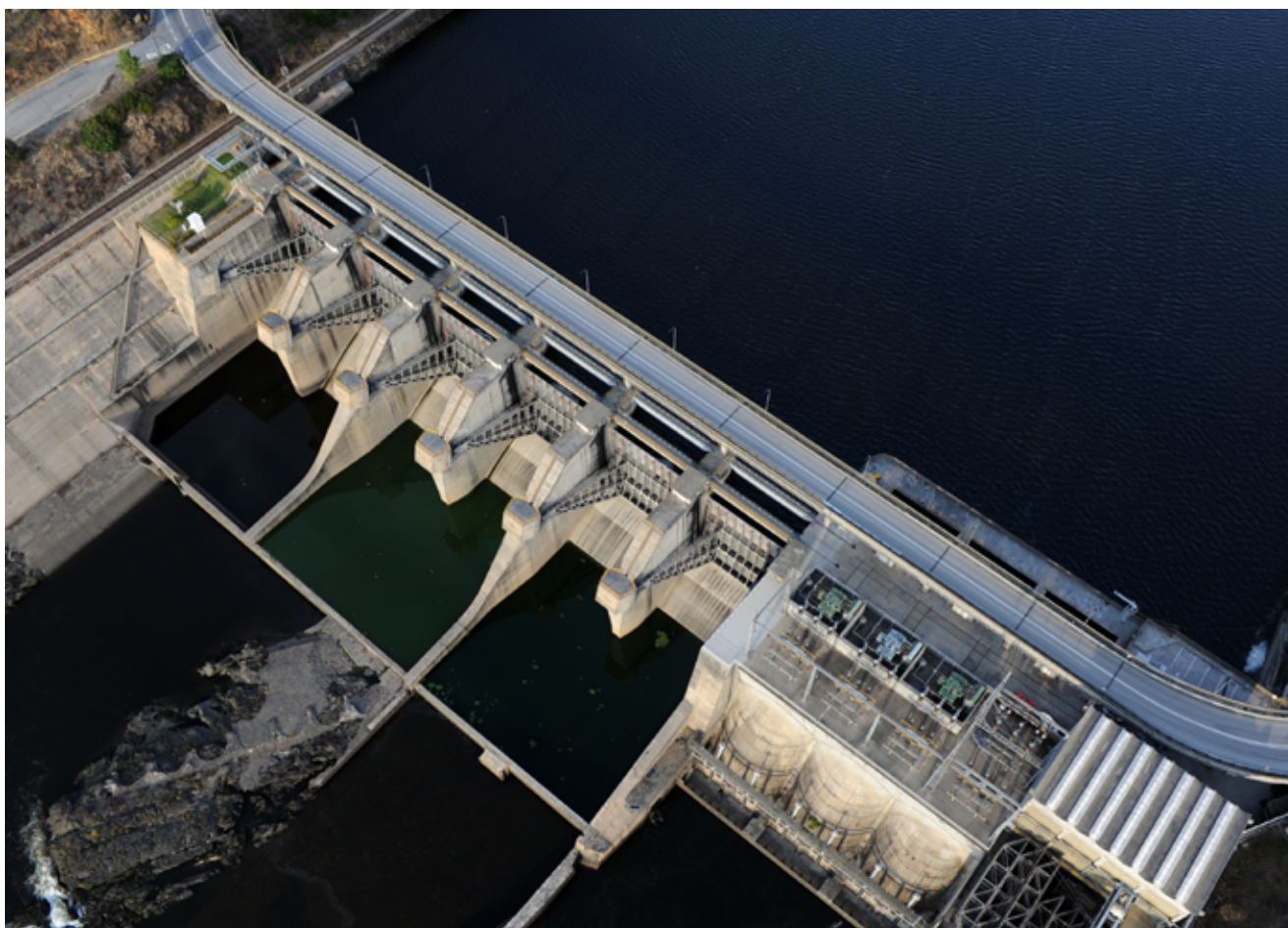
Barragem de Fratel
