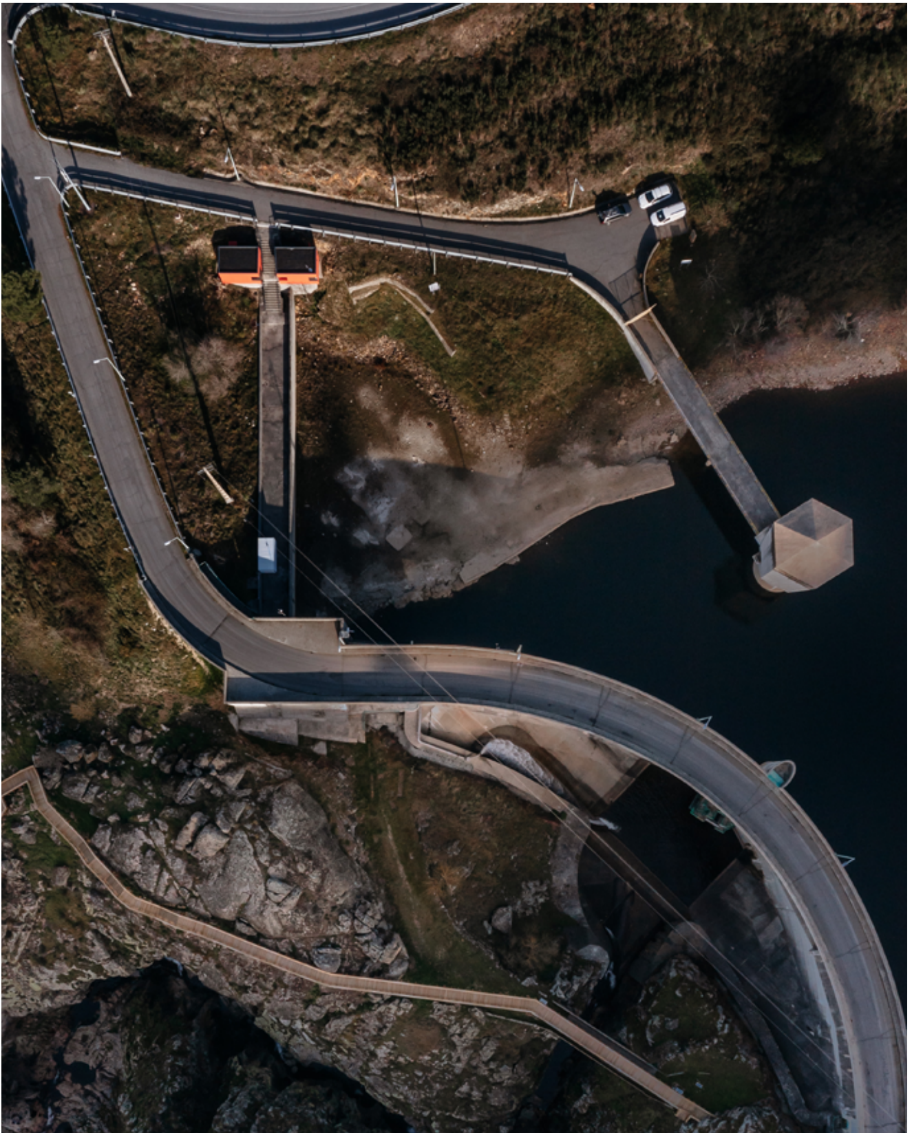
Barragem do Caldeirão
