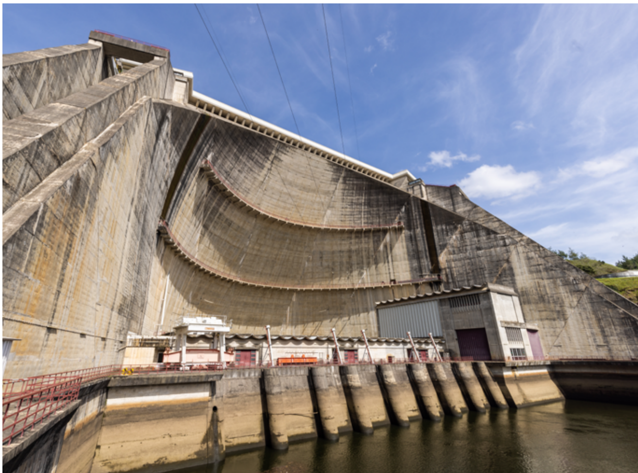
Barragem da Aguieira
