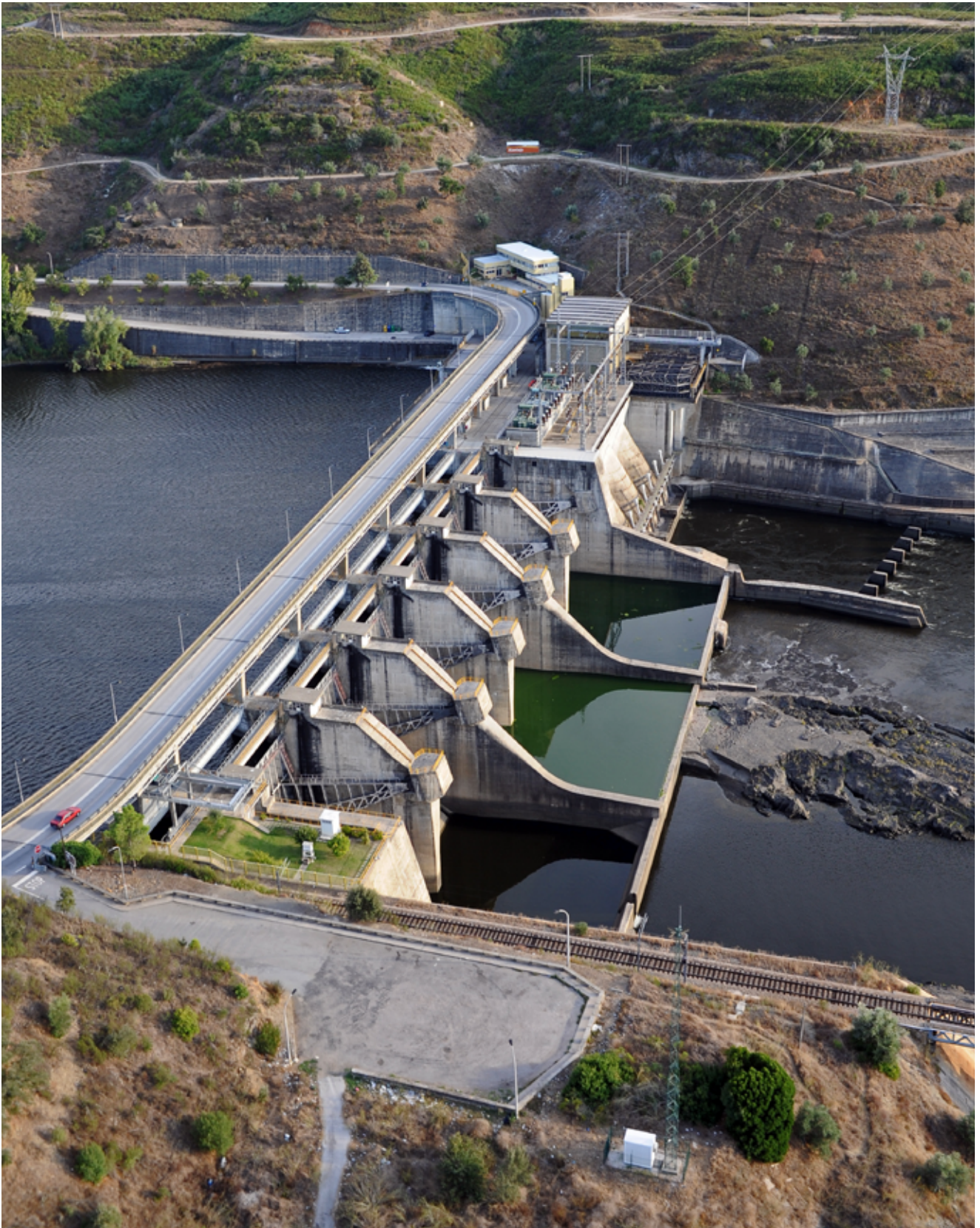
Barragem de Fratel
