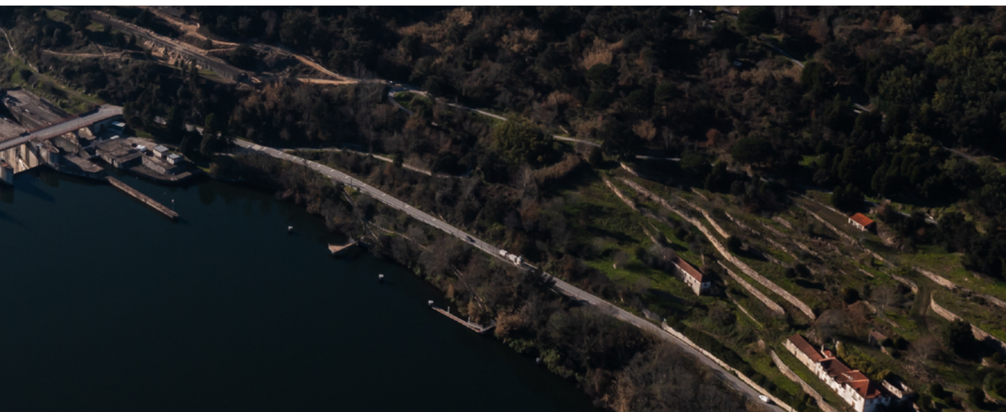
Barragem do Carrapatelo
