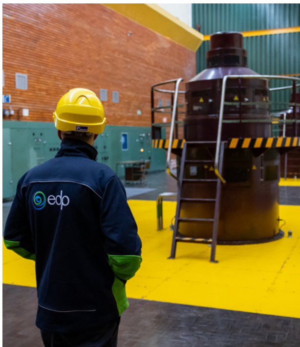
Barragem de Vilar-Tabuaço
