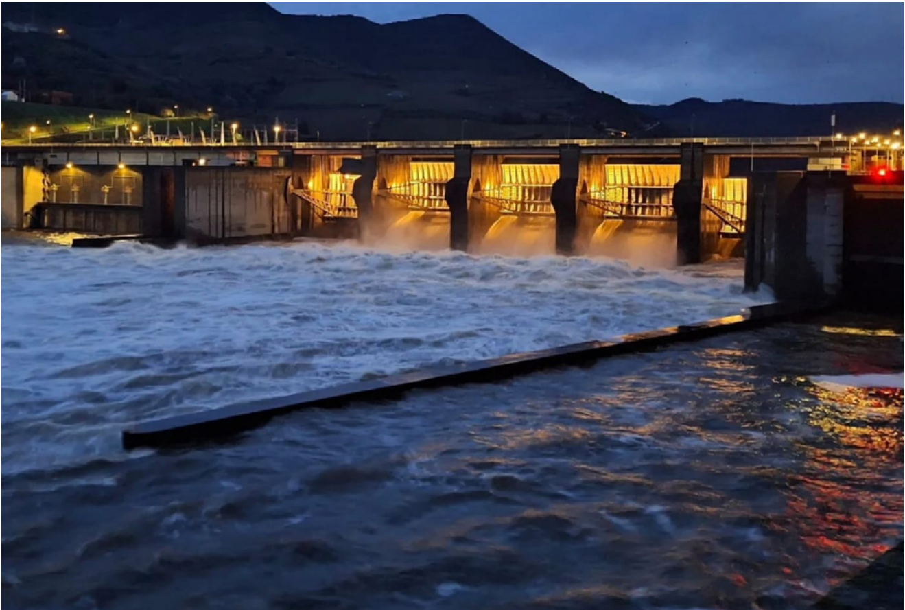
Barragem da Régua
