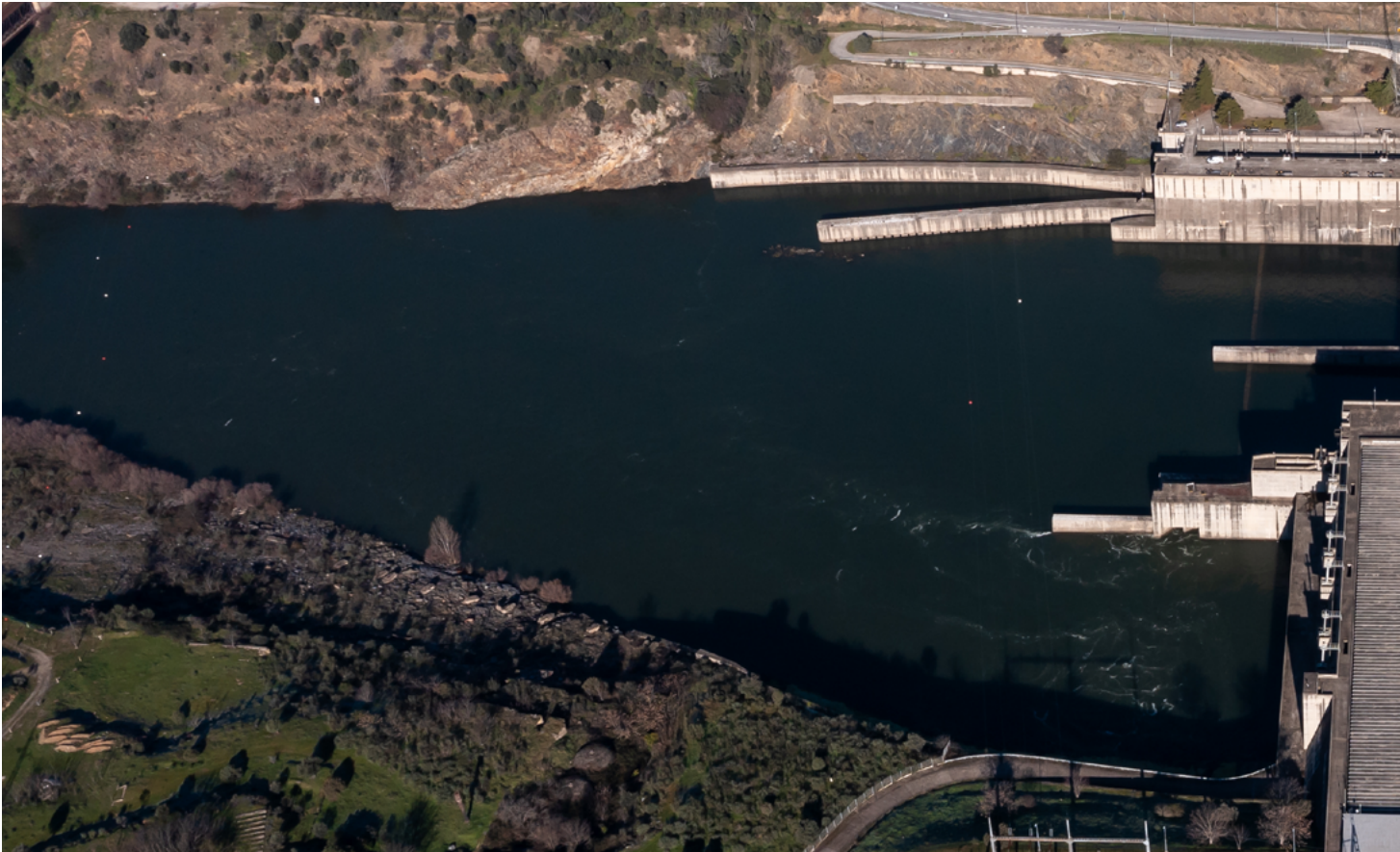
Barragem do Pocinho
