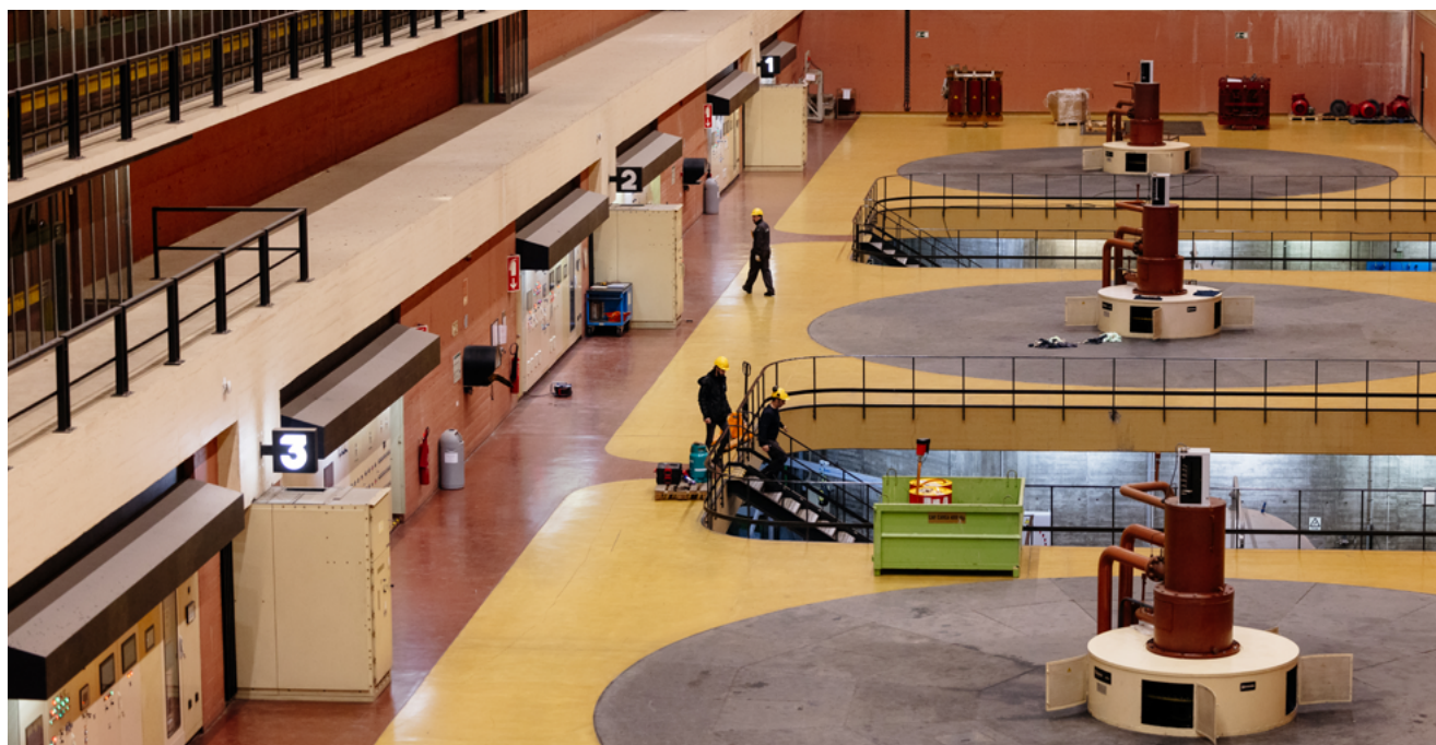
Barragem do Pocinho
