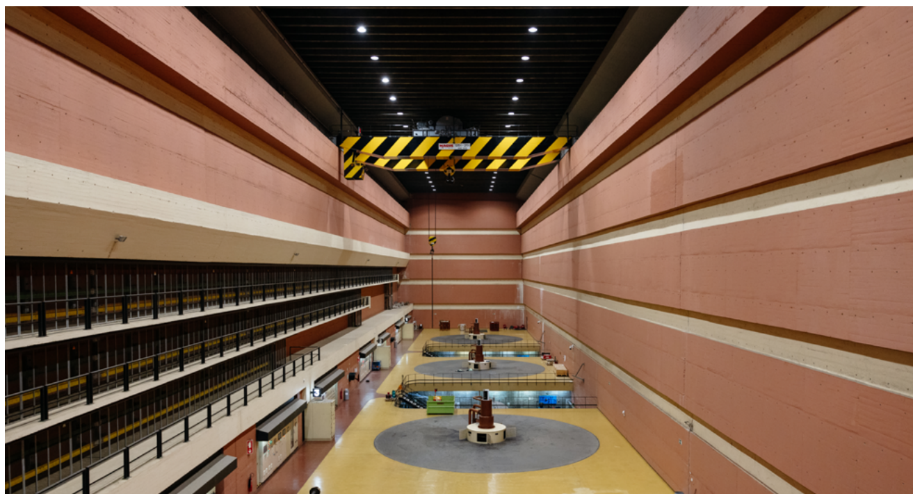
Barragem do Pocinho
