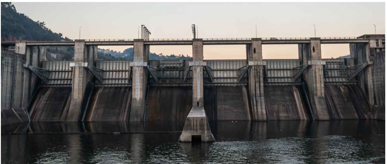
Barragem do Carrapatelo
