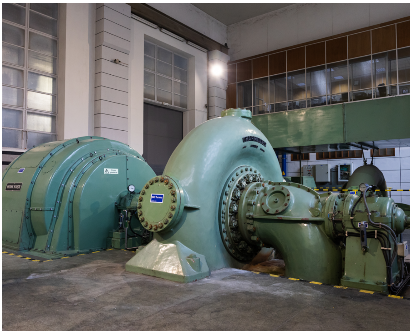
Barragem da Varosa
