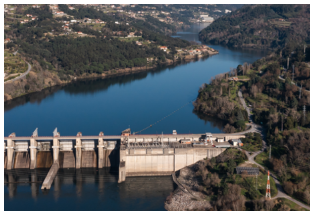
Barragem do Carrapatelo
