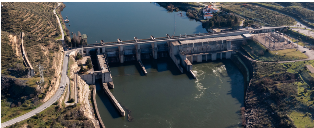
Barragem do Pocinho
