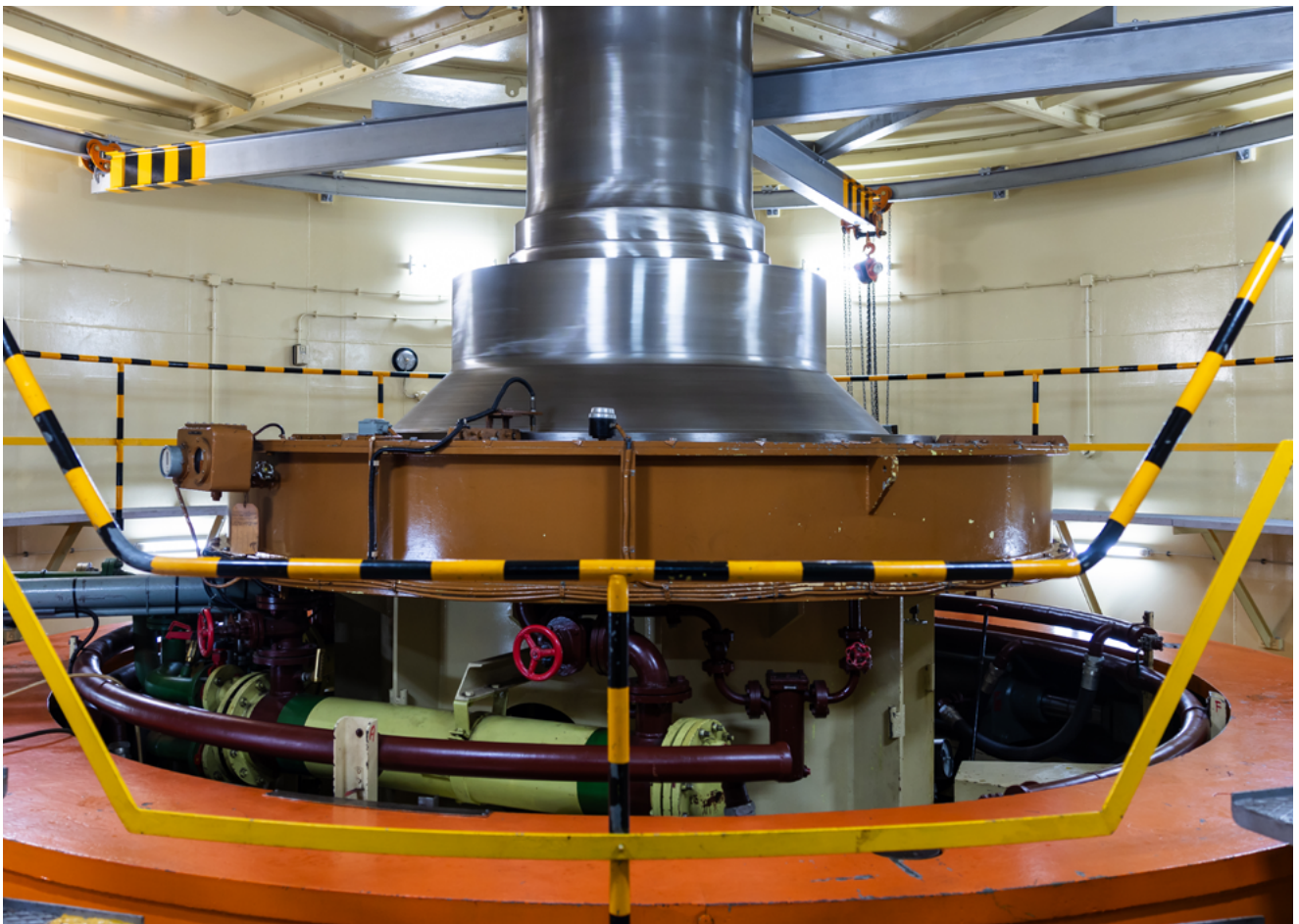
Barragem do Pocinho
