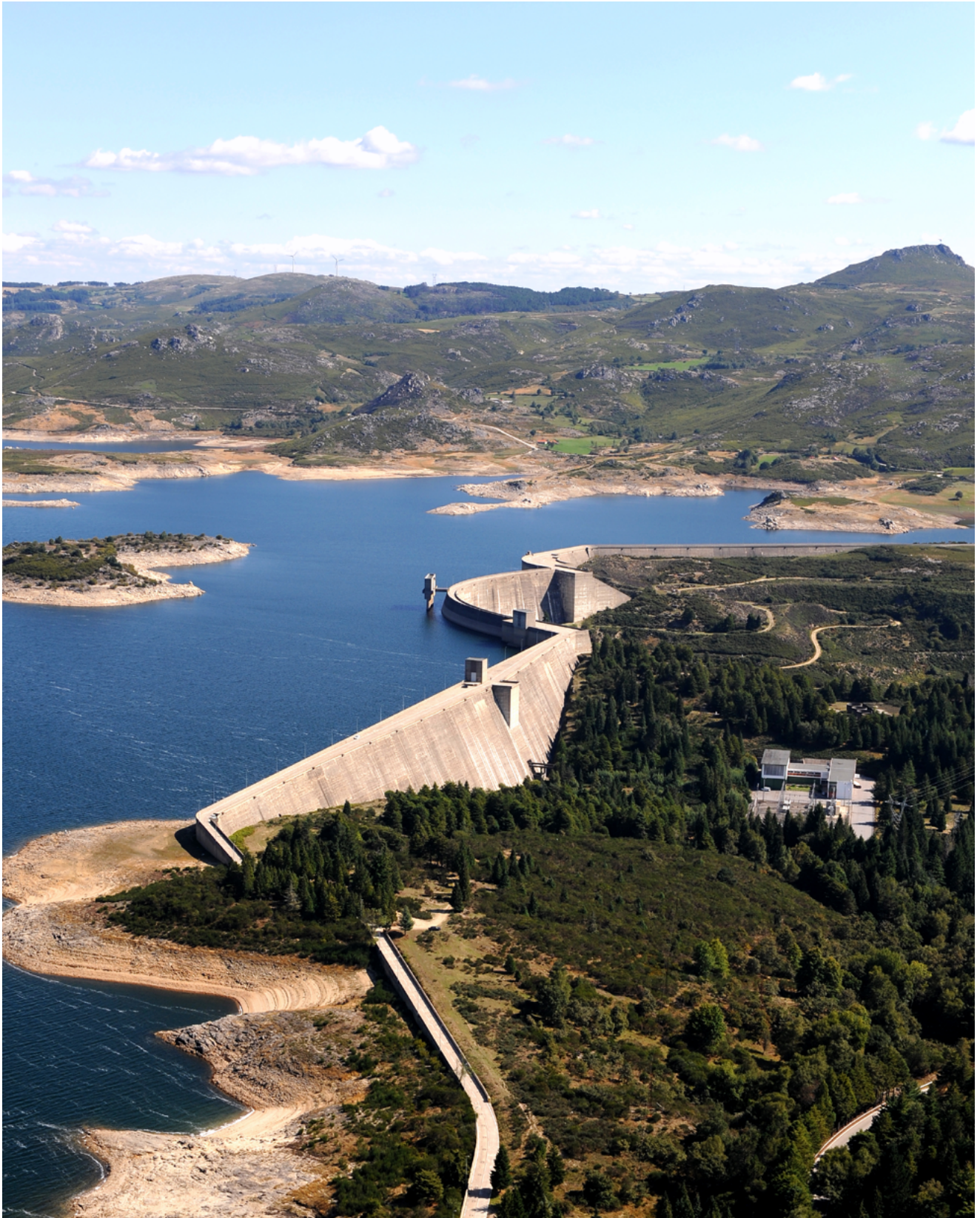
Barragem do Alto Rabagão
