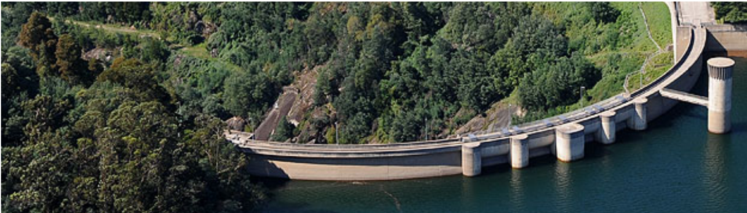
Barragem da Caniçada
