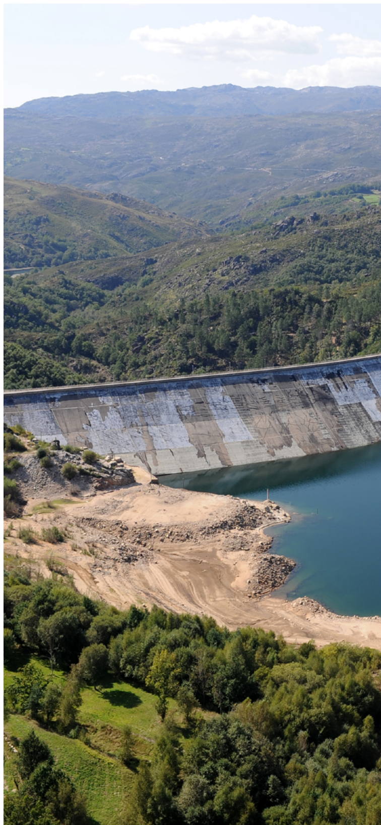
Barragem de Paradela
