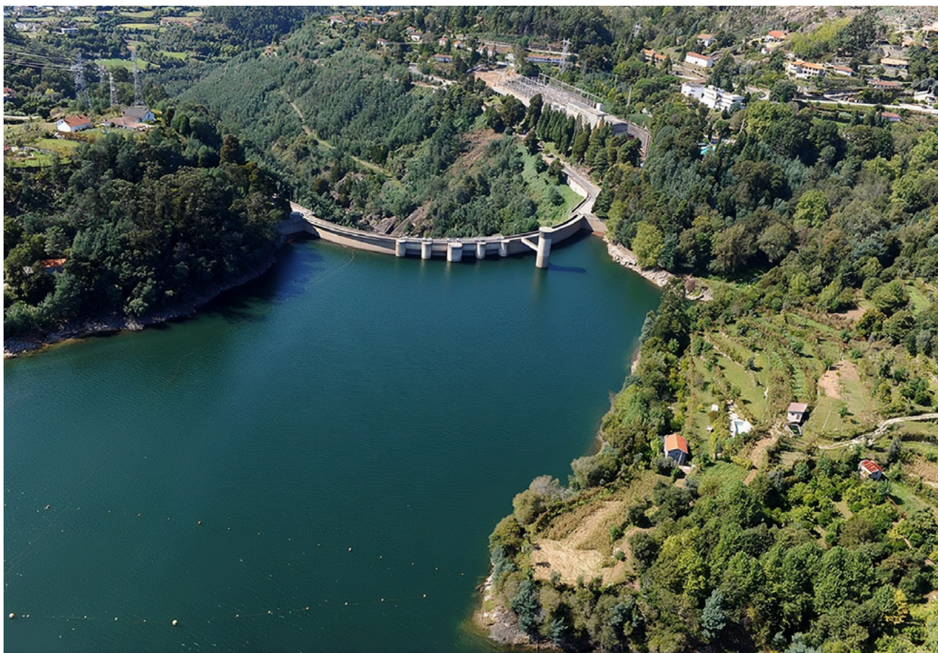
Barragem da Caniçada
