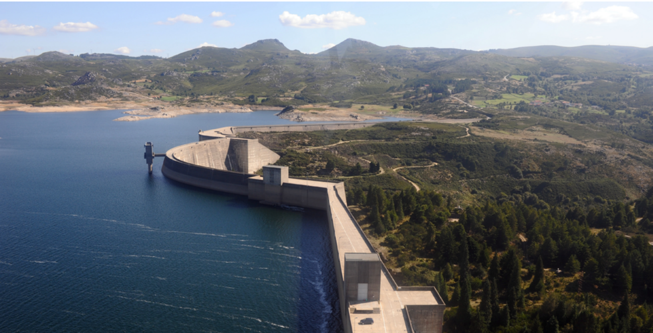
Barragem do Alto Rabagão
