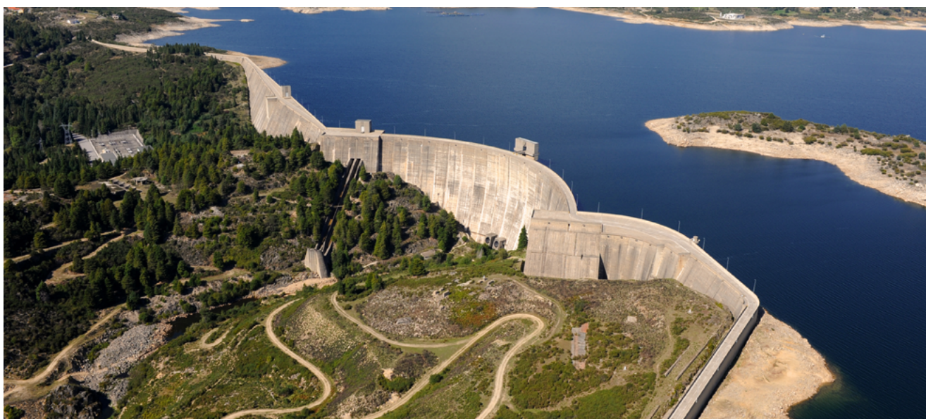
Barragem do Alto Rabagão
