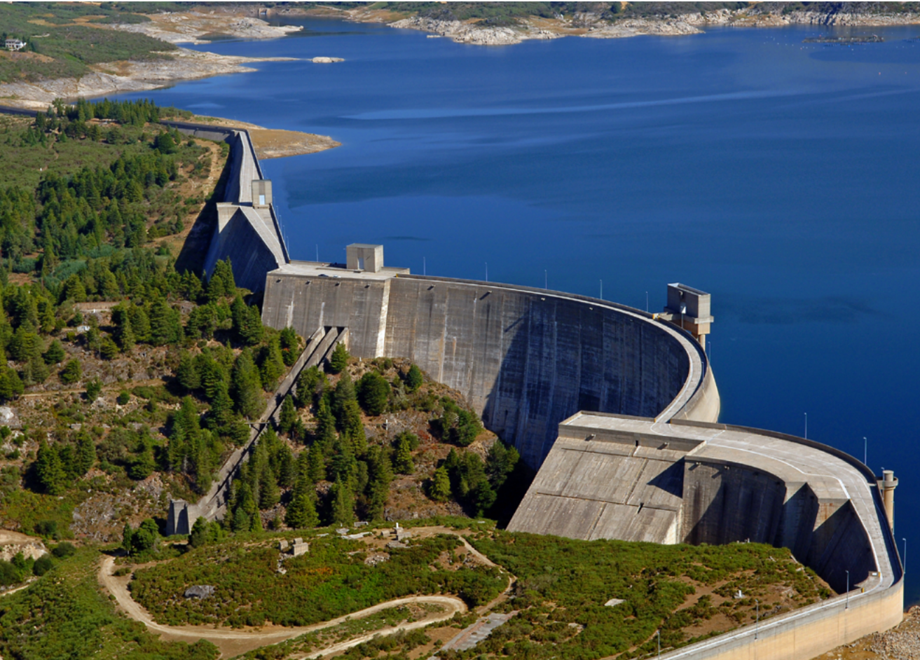
Barragem do Alto Rabagão
