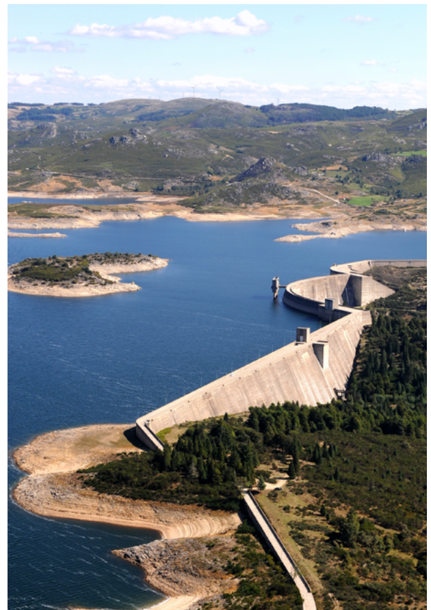
Barragem do Alto Rabagão
