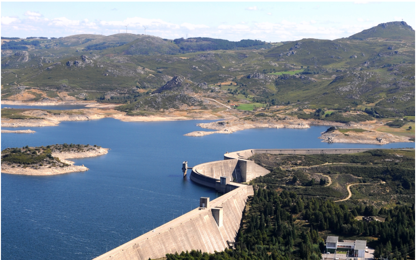
Barragem do Alto Rabagão
