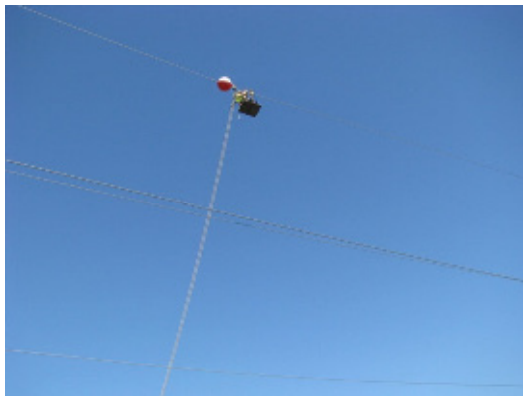
Fig. 37-38 Baliza de semnalizare montata
