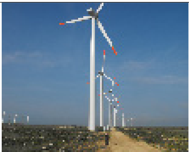
Fig 1.9 Eoliene cu ax orizontal cu rotorul de tip elice (foto Bulgaria)
