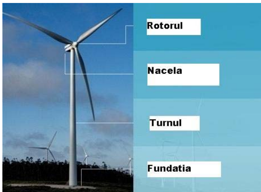
Fig 1.4 Componentele turbinei eoliene
