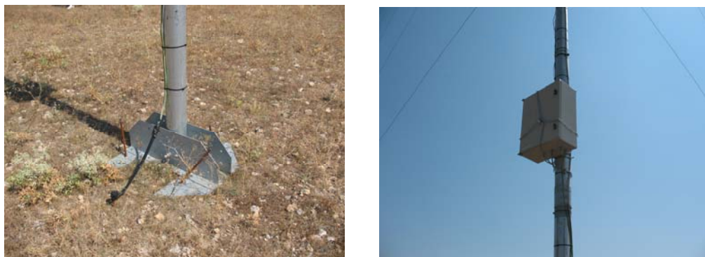
Dispozitiv de masurare, inregistrare si transmitere date despre vant existent pe amplasament
