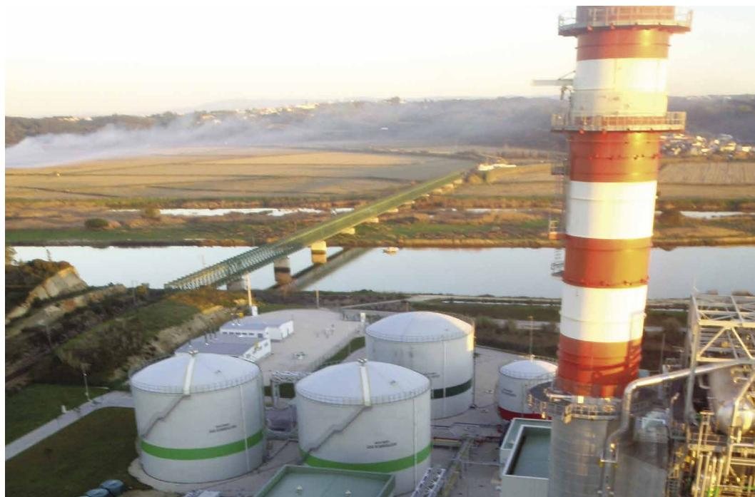
Esta Central é constituída por 2 grupos de tecnologia de "Ciclo Combinado" com queima de gás natural. A tecnologia implementada também permite o funcionamento, da turbina a gás, a gasóleo representando uma reserva de combustível para a segurança do sistema de abastecimento de energia elétrica.
