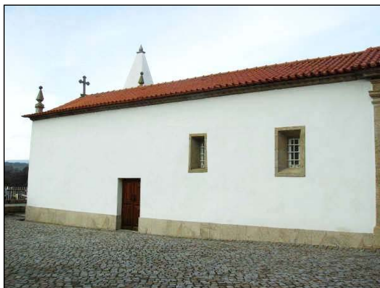
FOTOGRAFIA 4 – Igreja Matriz de Sejães – Porta Lateral na Fachada Lateral Sul
