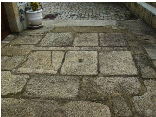
FOTOGRAFIA 24 – Lajes de Granito em frente da Fachada Principal
