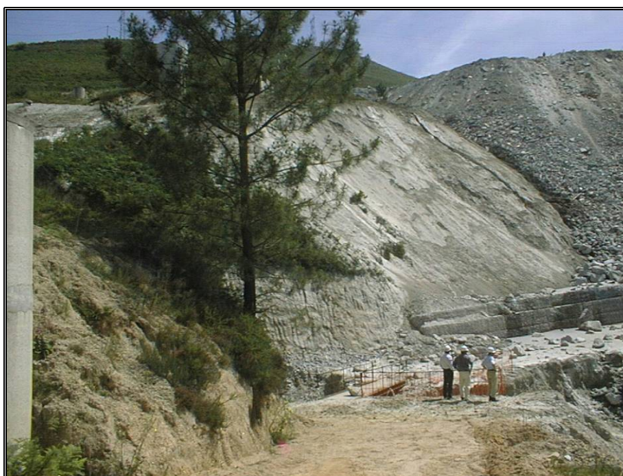
Fotografia 1 - Aspecto Geral de uma Escombeira – Venda Nova II
