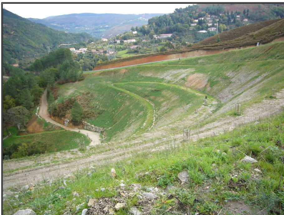
Fotografia 5 - Modelação e Hidrossementeira – Venda Nova II
