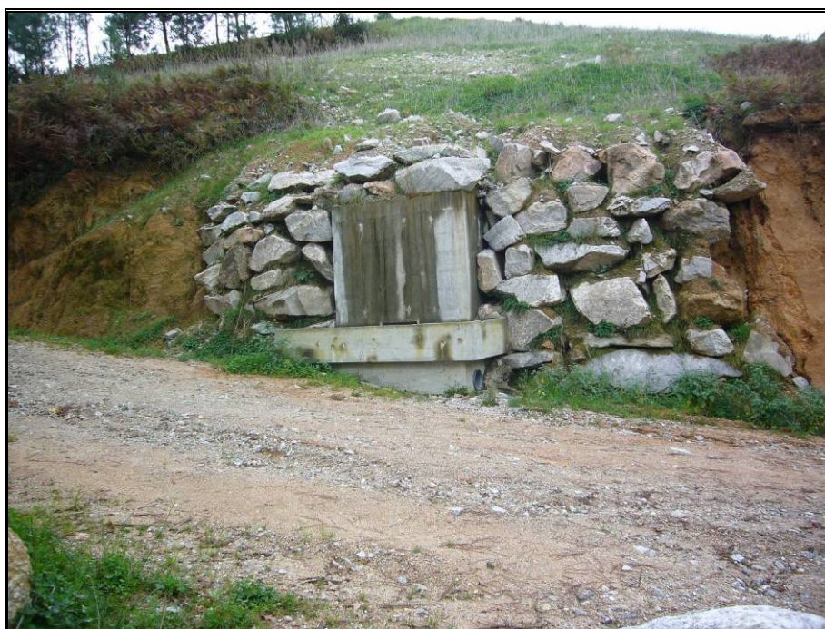
Fotografia 3 - Solução de Integração de Drenagem de Base – Venda Nova II
