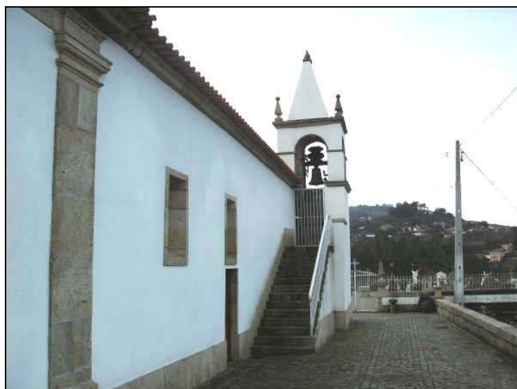
FOTOGRAFIA 2 – Igreja Matriz de Sejães – Janela - Fachada Lateral Norte
