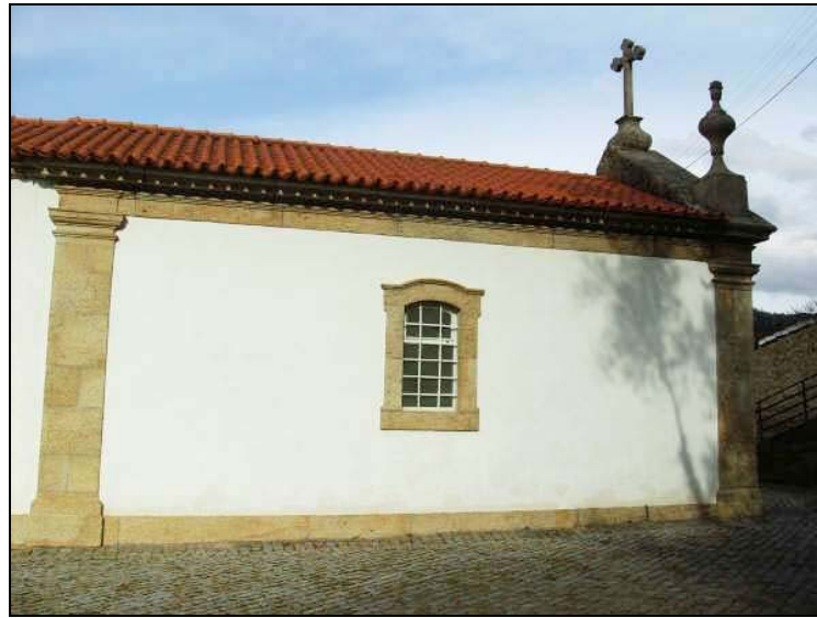
FOTOGRAFIA 5 – Igreja Matriz de Sejães - Porta Lateral na Fachada Lateral Sul – Janela
