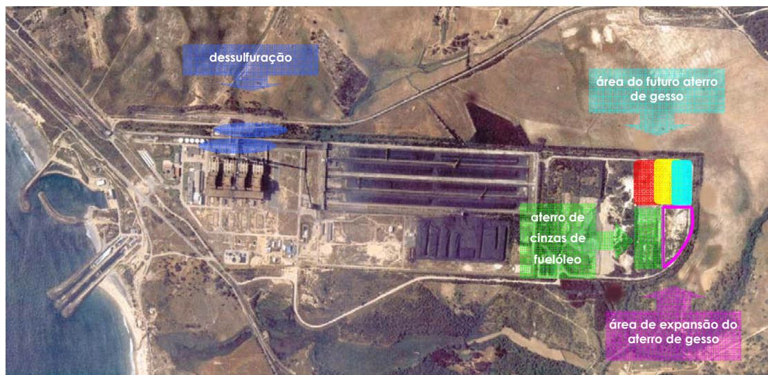
Figura 3-2 – Central Termoelétrica de Sines – localização do aterro de gesso
