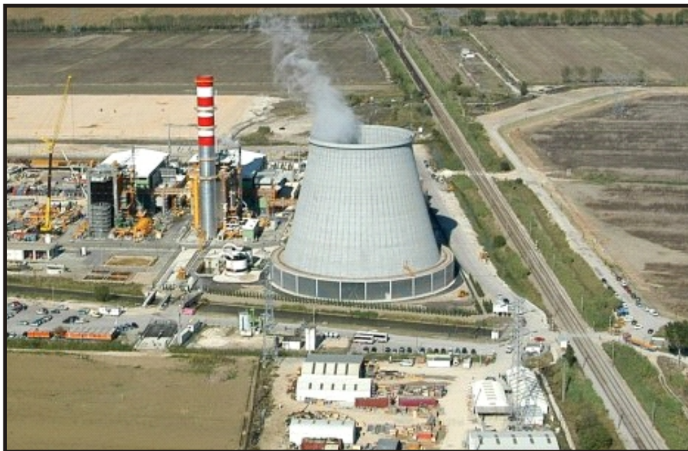
Torres de Refrigeração do Tipo Circular / Hiperbólica
