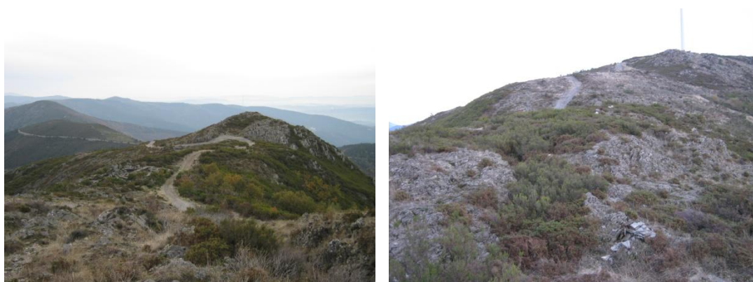
FIG. IV. 42 – Vista geral da área prevista para a implantação do acesso, vala de cabos e do aerogerador 12
