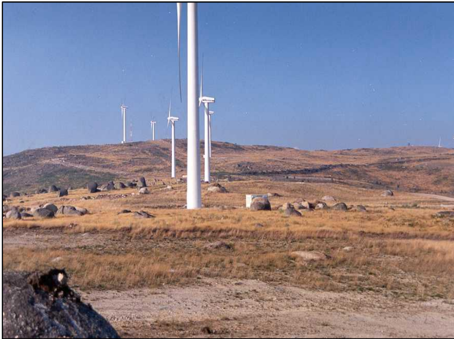
FIG. III. 4 – Plataforma dos Aerogeradores
