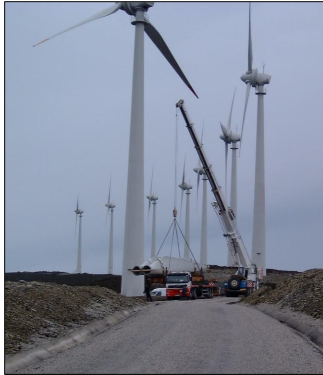
FIG. III. 5 – Acesso Principal do Parque Utilizado como Plataforma para Realização de Manutenção
