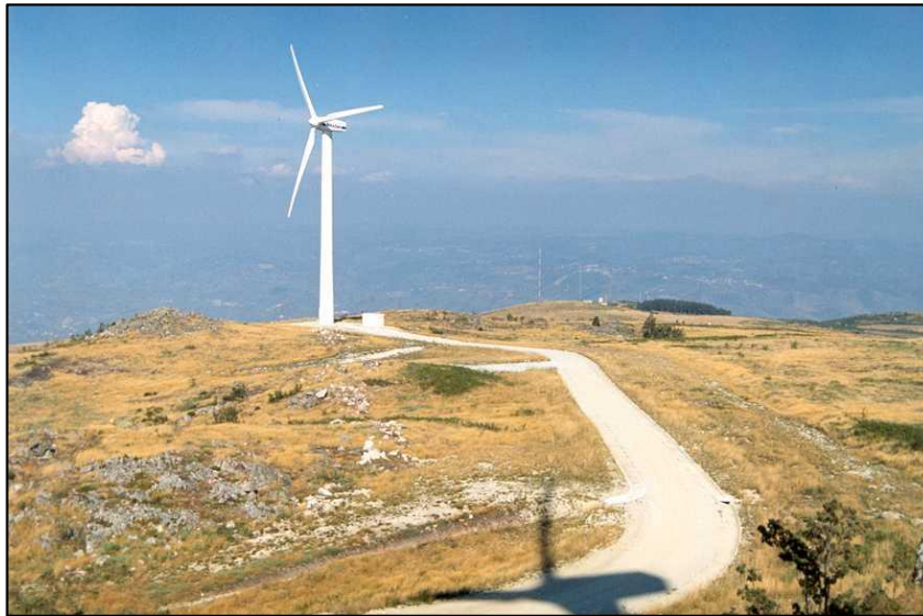
FIG. III. 9 – Vala Para Instalação de Cabo (ao longo da berma direita de acesso). Cerca de Um Ano Após Recuperação
