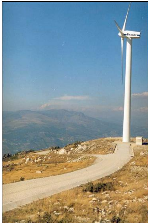
FIG. III. 3 – Acesso e Plataforma do Aerogerador
