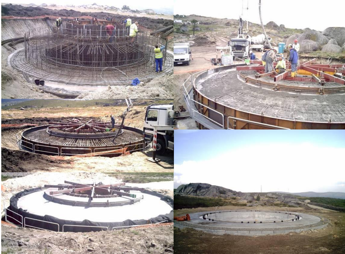
FIG. III. 6 – Fundação Pronta a Receber Torre de Suporte dos Aerogeradores
