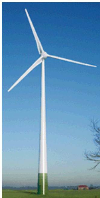
FIG. III. 2 – Aerogerador ENERCON E82 / 2 MW
