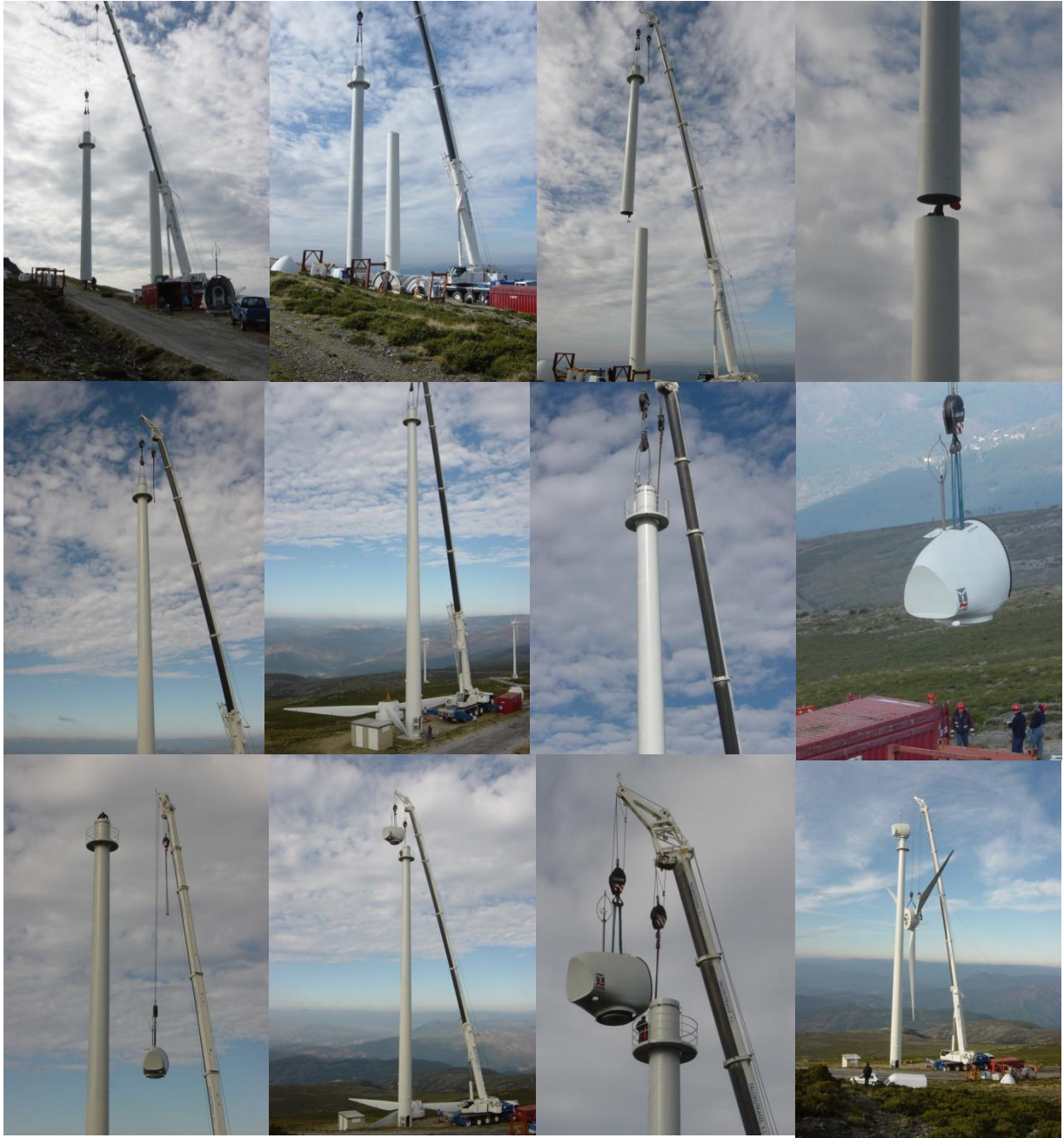
FIG. III. 7 – Aspectos da montagem da torre dos aerogeradores
