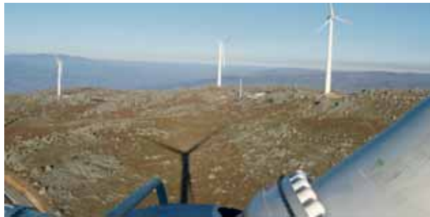
Fonte da Quelha Wind Farm
