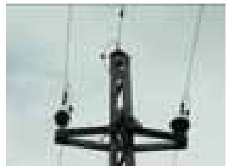
Figura 2 – Tipologia Triângulo rígido (15 kV)
