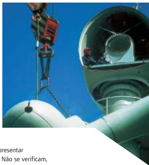
Fonte da Mesa – Montagem de aerogerador.
