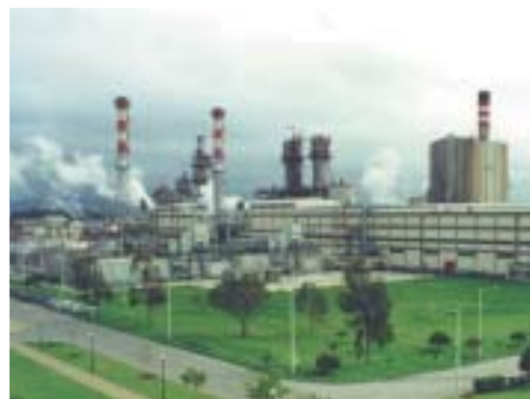
Central de Cogeração da Soporgem.
