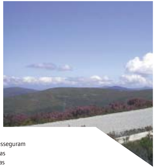
Cadaífaz – Construção de acessos.
