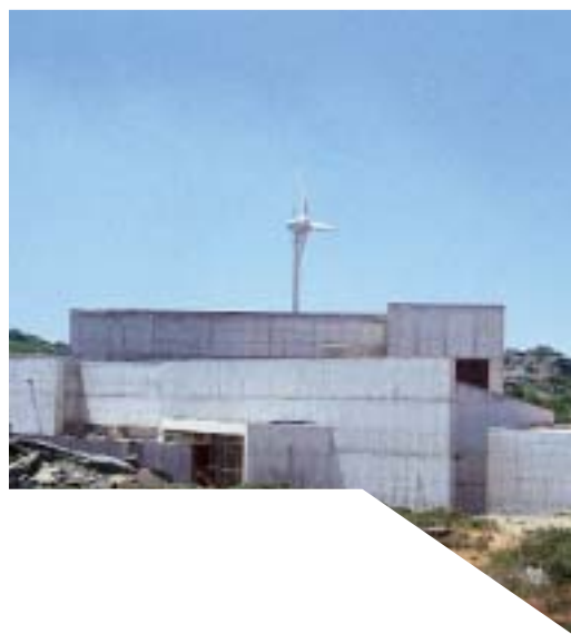
Pena Suar - Integração paisagística da subestação.
