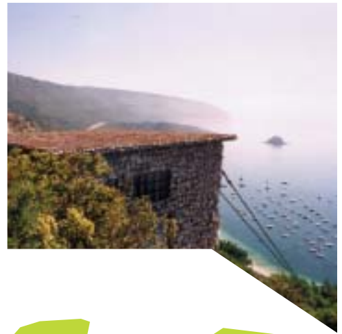
Posto de Transformação – Serra da Arrábida.
