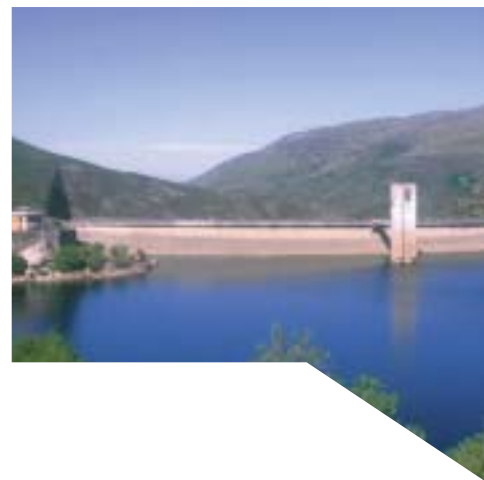
Central Hidroeléctrica de Vilarinho das Furnas.
