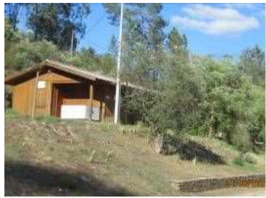
Edificação de apoio à praia fluvial de Taberna Seca
